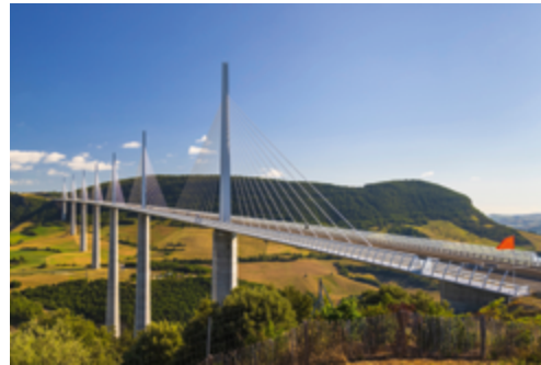
Viaduc de Millau
